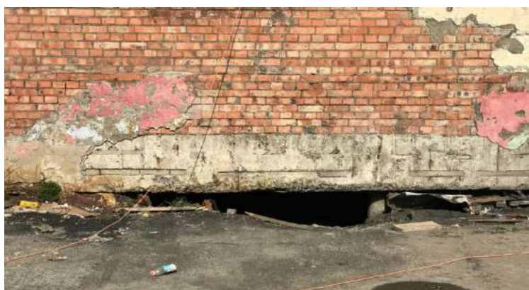
Рис. 6. Фотофиксация - ростверк с наружной стороны.
