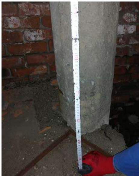
Рис. 3. Фотофиксация - свая в пространстве подполья.
